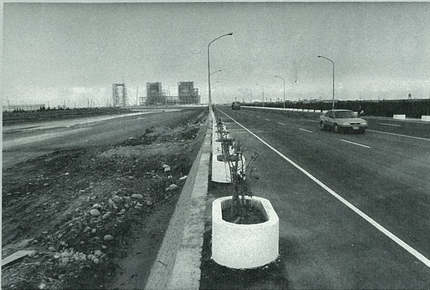
火力發電廠右側緊臨麗水村，左側是大肚溪口，第一號機組預定在明年6月開始啟動，比計劃中提早一年。
