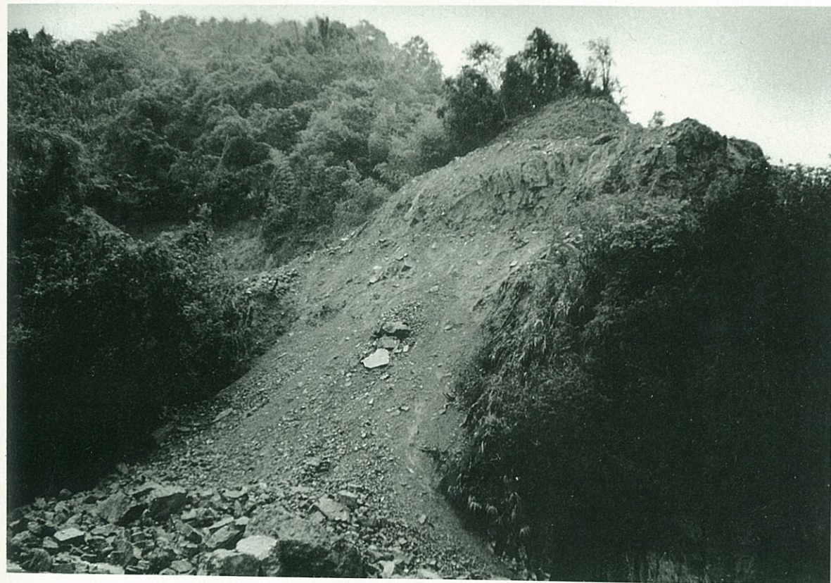
開路以後，植被多被破壞，岩石常年傾瀉，形成大坍方。
