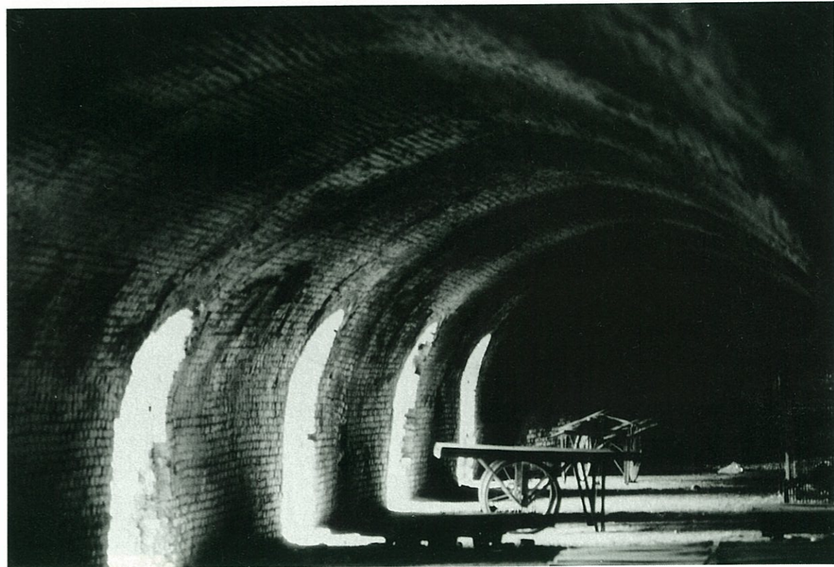
傳統八卦窯因製磚的成本，遠比電動磚窯高，現在大多已停止生產。
