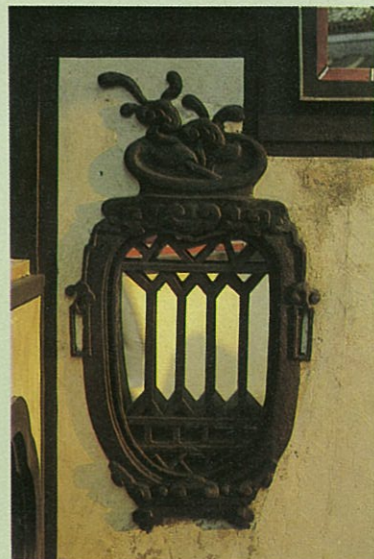
修復後的瓶形漏窗。
