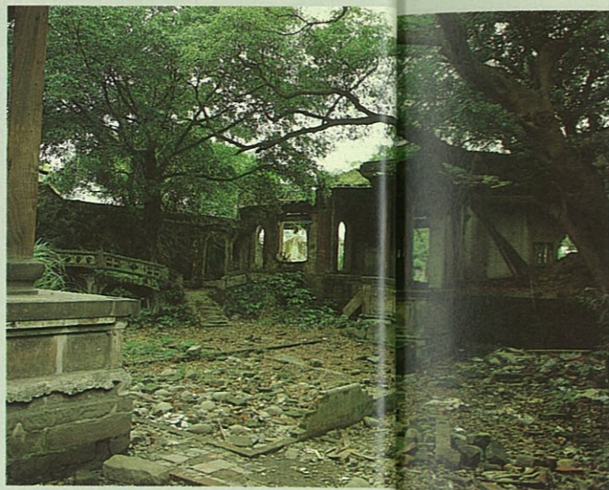
修復前之方鑑齋，水池已乾。
