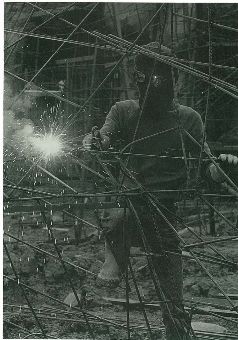
新動物園的假山假石，全是這樣「假造」出來的： 先打骨架、綁網、再噴灌水泥漿。
