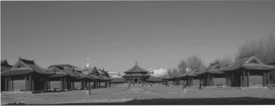
清朝入關前，皇宮內的大政殿及殿前的十王亭，從建築上反映了滿人的八旗制度
