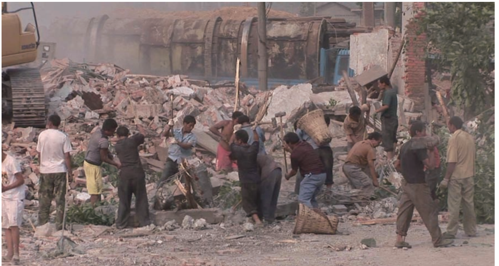
在《1428》片中，呈現了居民在四川大地震過後，如何在傾頹的建築殘蹟中，取走金屬建材變賣的現象。
