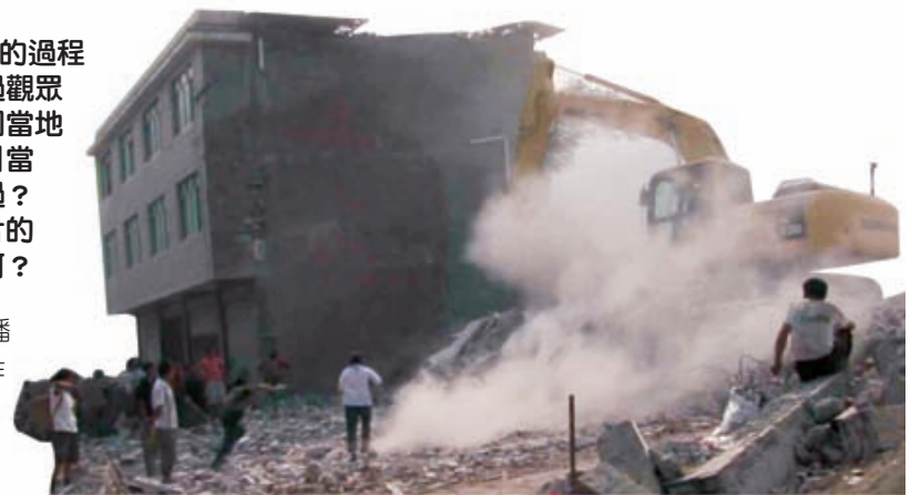
川震災區居民在施工現場等待搶拾鋼筋建材變賣。
