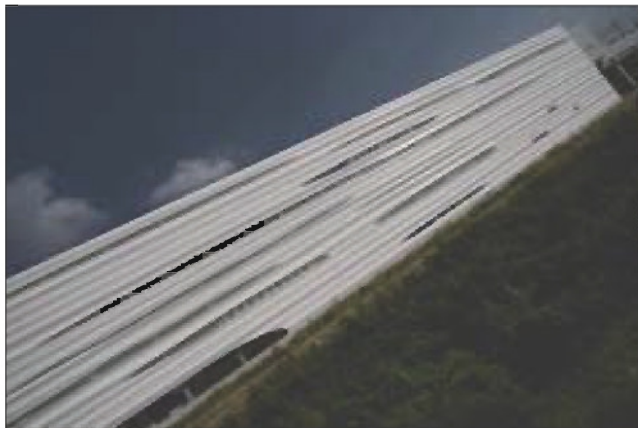
筑波高速鐵道 Kashiwanoha-Camp車站
