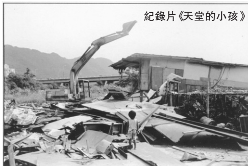
北縣三鶯大橋下的原住民聚落連建被拆
