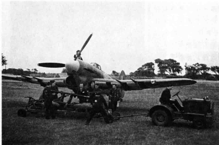
↑地面部队在给一架“台风”号战斗轰炸机装上炸弹。其带有的“诺曼底登陆日斑纹”，表明其是在1944~1945年间使用的。
