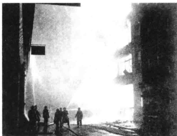
↑ 在1940年的闪电战期间，消防人员忙于给伦敦着了火的建筑进行灭火救援。
