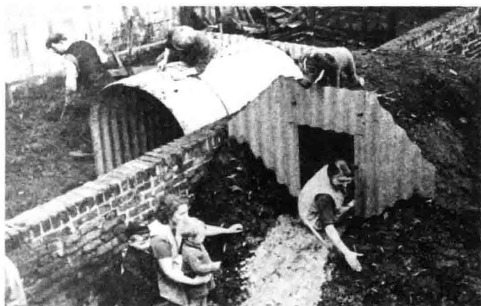
↑ 在“虚假战争”期间，英国家庭正在建造安德森式的掩体，从而对德国的空袭做出事先预防。
