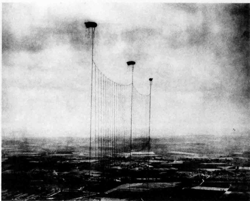
↑伦敦东北部，一排系在地面上的热气球在空中拉起了一道“绳索栅栏”。如果有哪一架不长眼的飞机冲进来，就会像冲进了碎纸机一样被切掉双翼。
