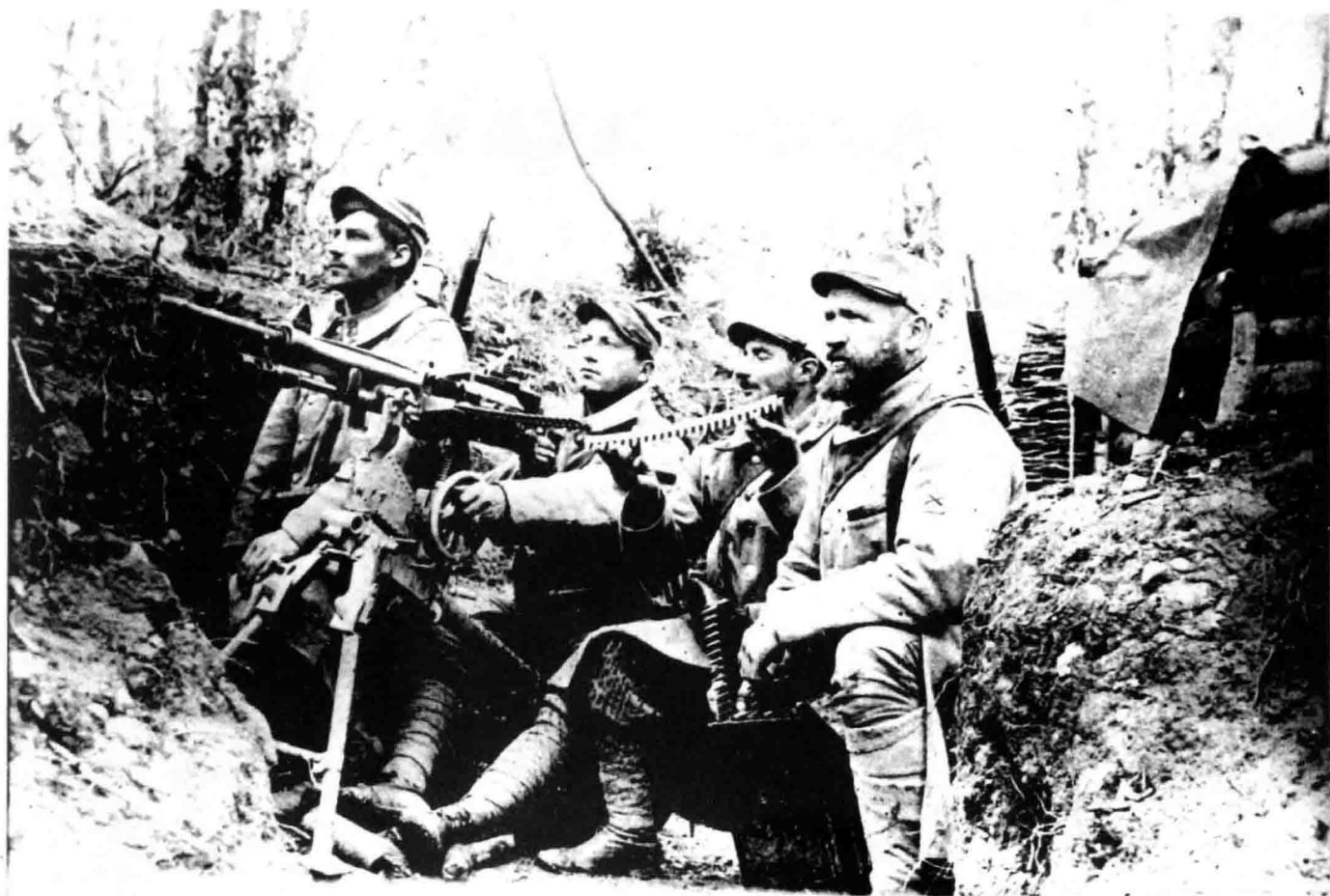
↑法军于1900年引进了第一批霍奇基斯机枪，又于1914年改用了该枪的气冷版。原版机枪只有30发子弹的供弹带，于1915年被249发子弹的金属带取代。
