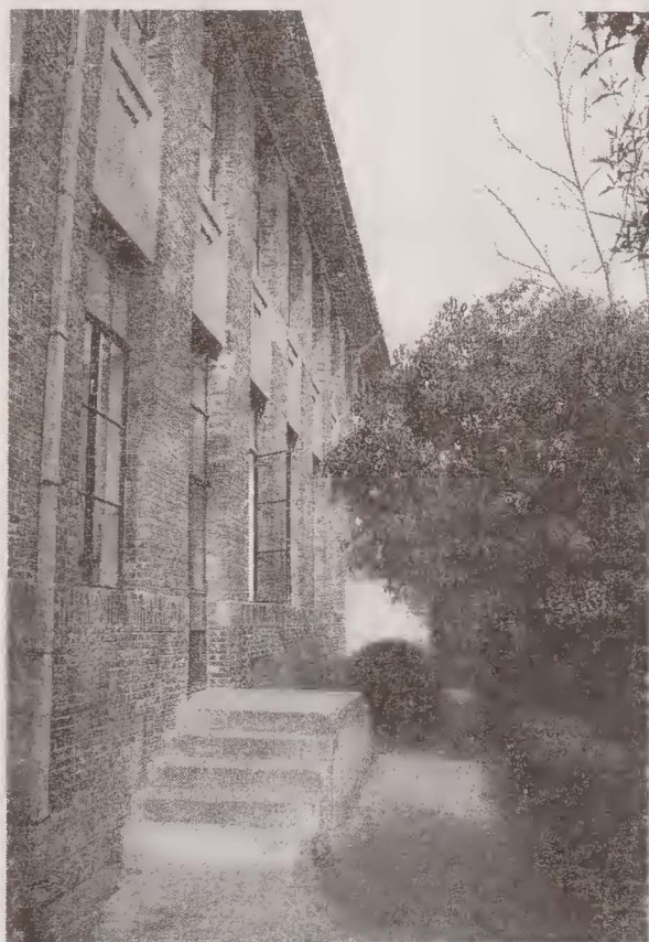
行政院南楼南面的防空洞进口
