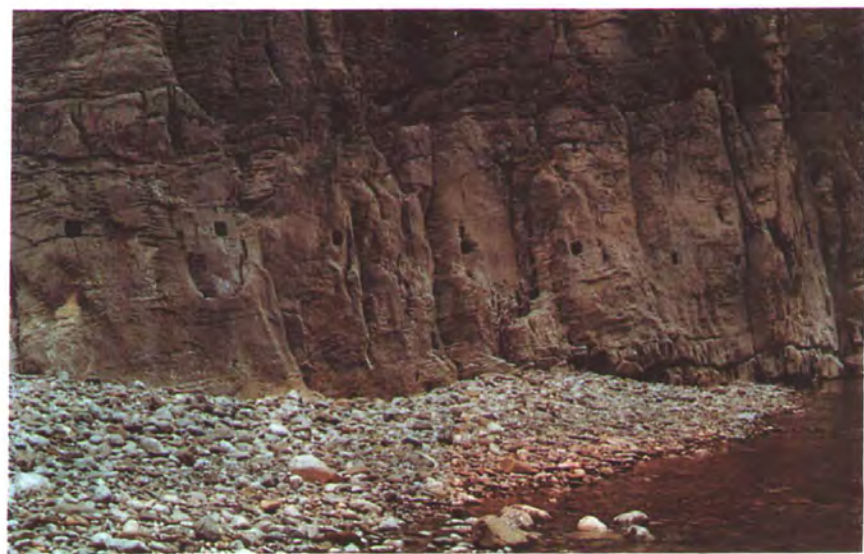
3 四川省大宁河岸架设输卤笕管的古迹 (廖渝方摄影)
