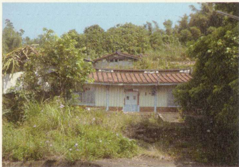
► 尖山下的舊屋 (2012.10.12)。
