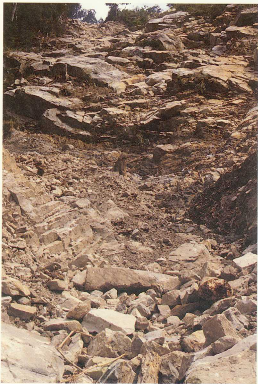
■ 崩場岩層正是山塊不整合面，且原為該坡壁的排水小澗所在處。
