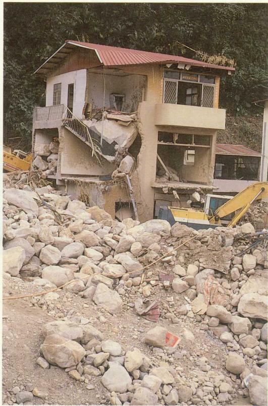
■ 土石流開口處及附近，由於住宅匯聚，造成屋毀人亡。
