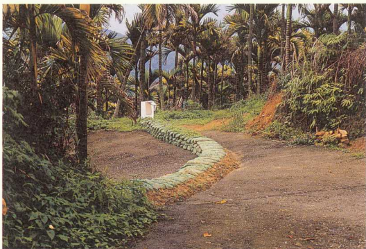
■ 其上方採圍堵降雨的地面逕流、填補縫隙，
