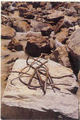
■善天寺崩場地下方蛇籠，見有該植生工程掉落的鋼筋到處散布。
