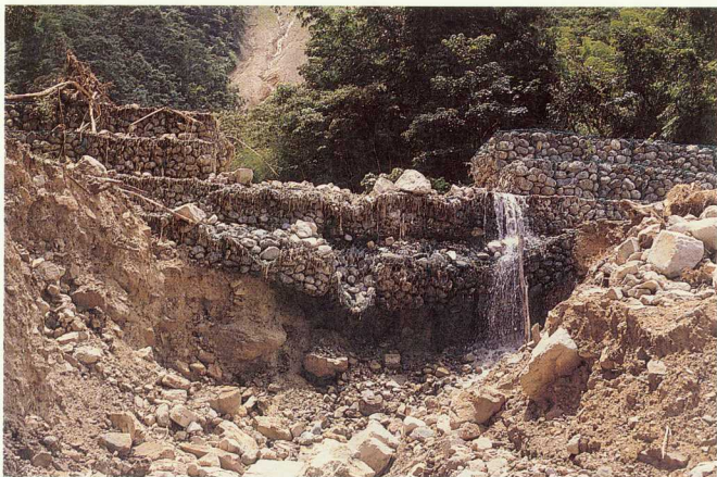
■善天寺崩場地下方蛇籠，見有該植生工程掉落的鋼筋到處散布。
