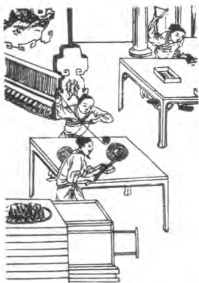
图 11-5 明代使用“冷拉”的造针方法
