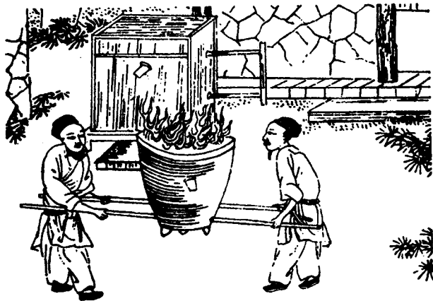
图 7-5 明代铸造大钟和大佛像时所用的冶铁炉 (采自《天工开物》)
