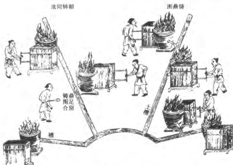
图 6-2 明代铸鼎时所用的手风箱冶炉
