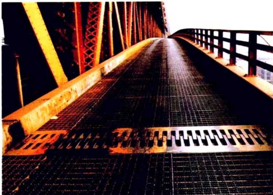
图6-16 桥梁接合处以及人行道上的空隙都是为物质的热胀冷缩预留的空间。
