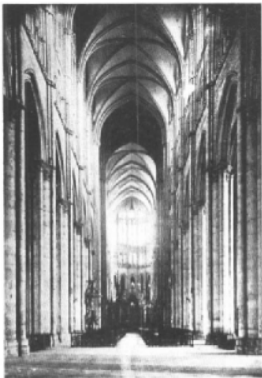
129. 哥特式建筑内部：亚眠主教堂，中殿为罗贝尔·德·吕札什建造，公元 1218—1236 年，半圆壁龛 1247 年完成。
