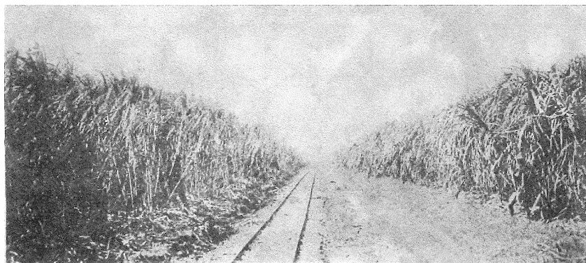
甘蔗運輸：甘蔗採伐以後，如不於短時間內運至工廠，糖分即將減少，加上甘蔗身長，台灣道路又不甚好，並不利於甘蔗運輸。隨著新式製糖工廠的紛紛設立，為滿足生產能力巨大的製糖工廠之所需，各製糖公司紛紛鋪設鐵路軌道。該軌道除供運蔗外，亦對外開辦營業服務地方，輸送民間客貨。日治時期台灣的地方交通設施，大部分為製糖公司所提供，且為製糖公司所控制。圖為搬運甘蔗之列車軌道。（中央研究院台灣史研究所古文書室藏，TP02130303）
