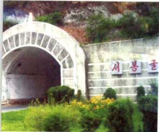
从平壤到开城要经过许多隧道，这是隧道口
