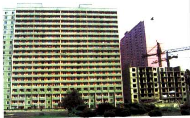
在平壤难得一见正在建造的楼房
