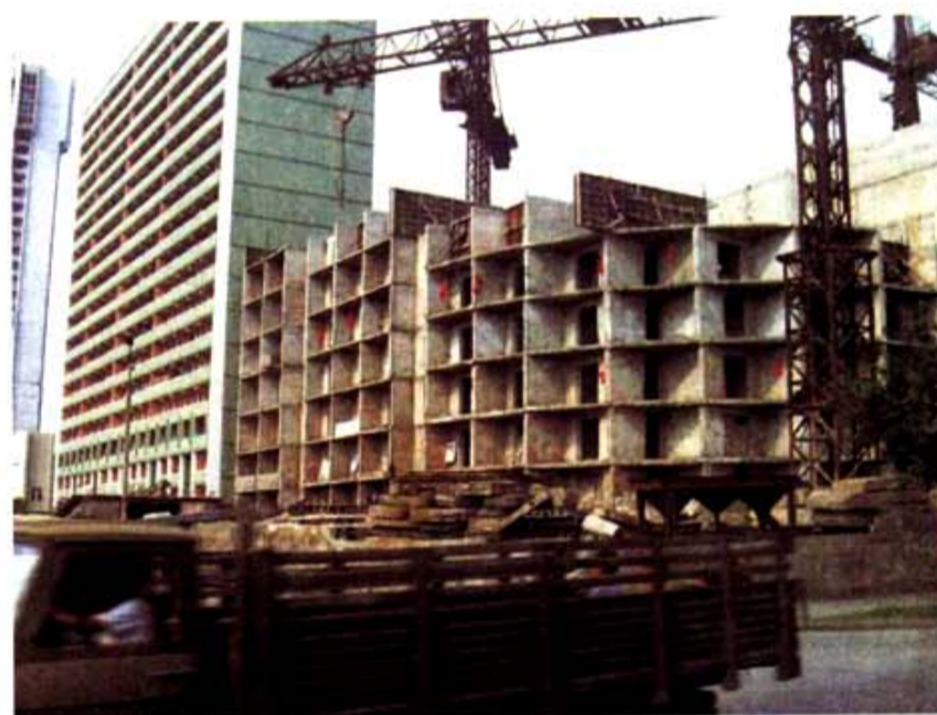
正在建造中的楼房
