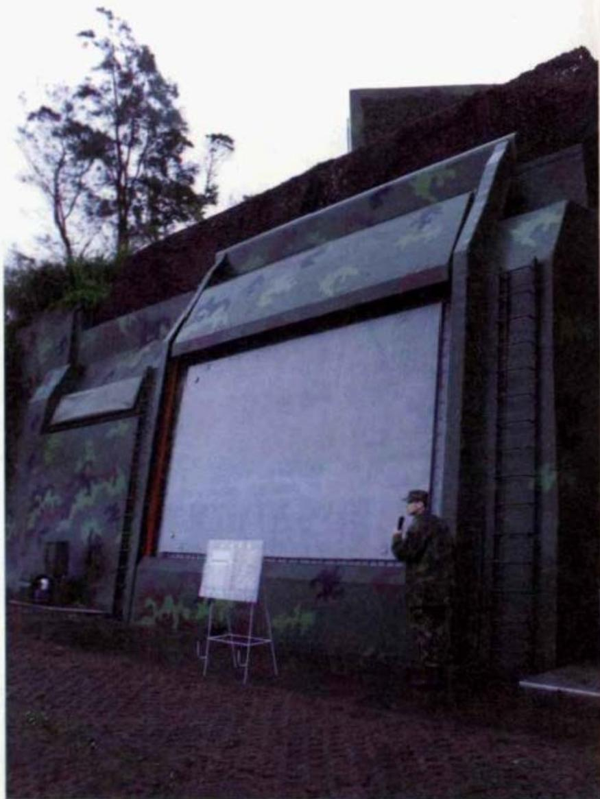
固定式長波相列雷達陣地，其天線面長33.58m、寬10.67m、高53.21m，共由5,632個子天線構成，採用S波段，共有10個可用頻道，使它具有多目標偵追，以及執行飛彈上/下鍊等能力。
