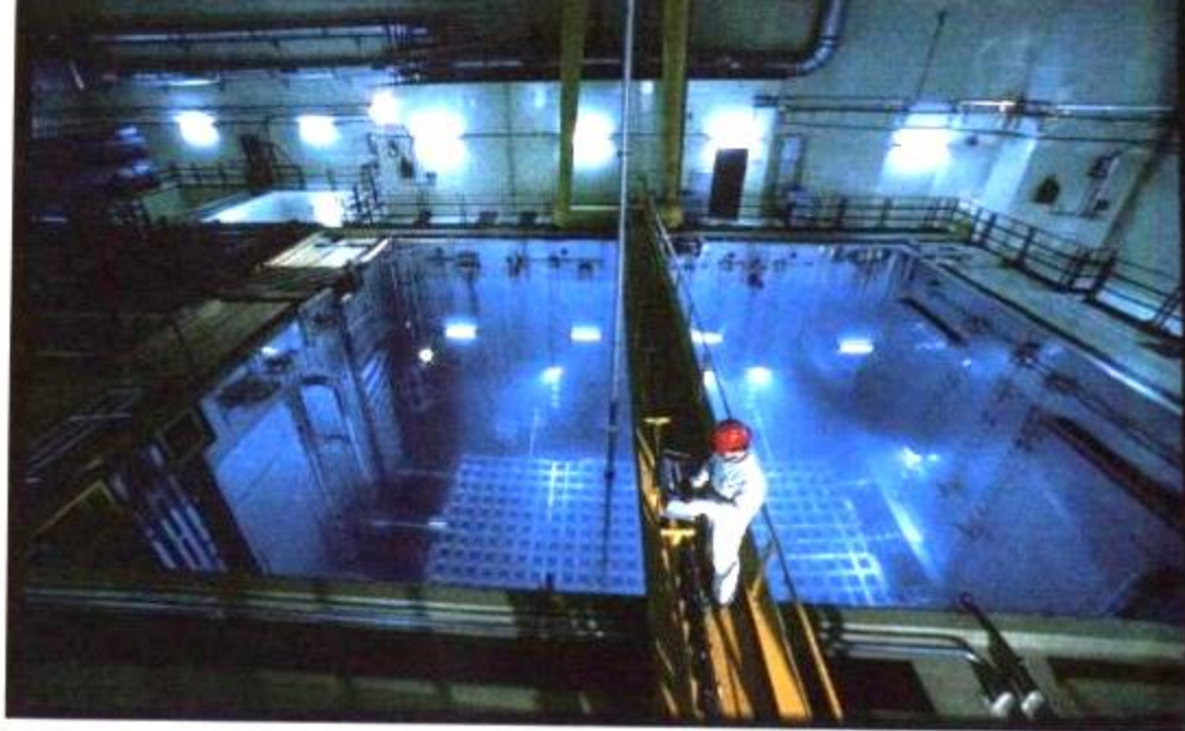
图 6-18 核电厂面临的一个问题是, 如何处理使用过的放射性燃料棒。图中的法国核电厂是将燃料棒储存在极深的水池中。
