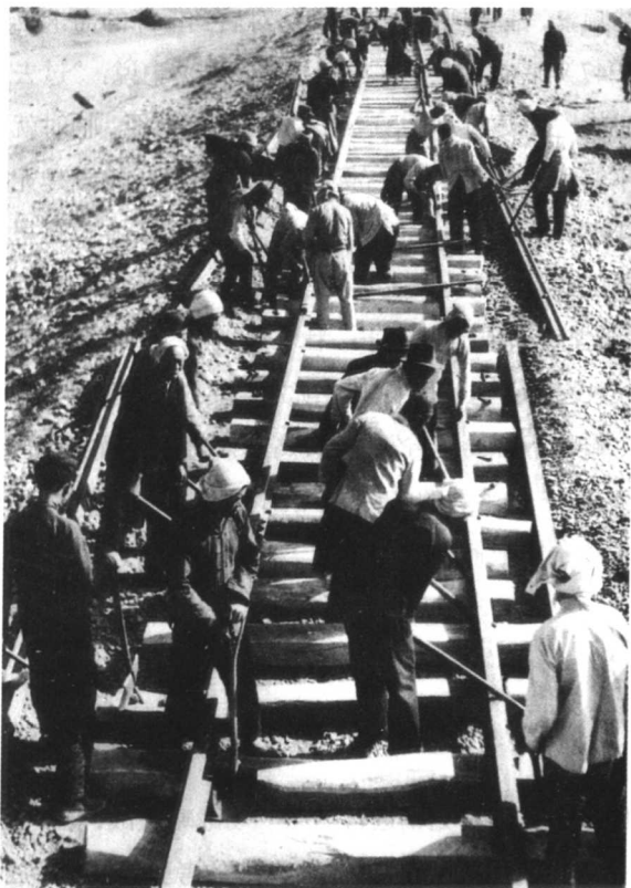
东北人民积极修复铁路
