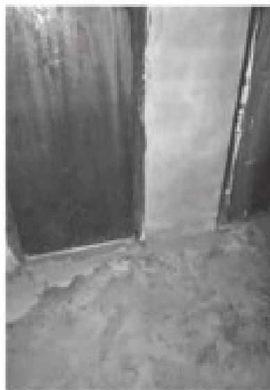
曾被洪水淹過的金庫遺址
