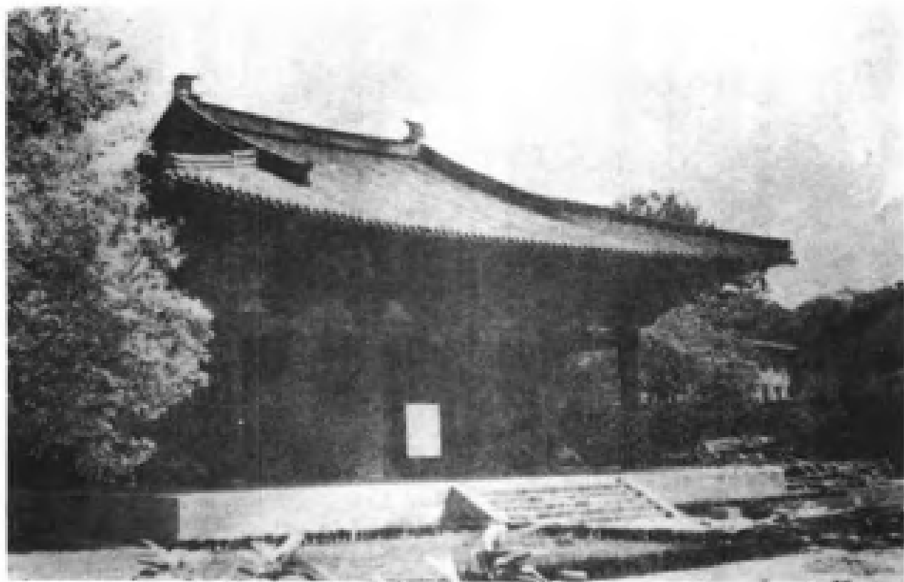
福州华林寺大殿（宋）——江南现存最古老的木构建筑
