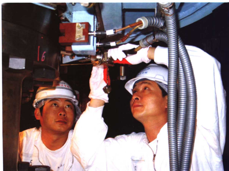
一回路主泵探头回装
