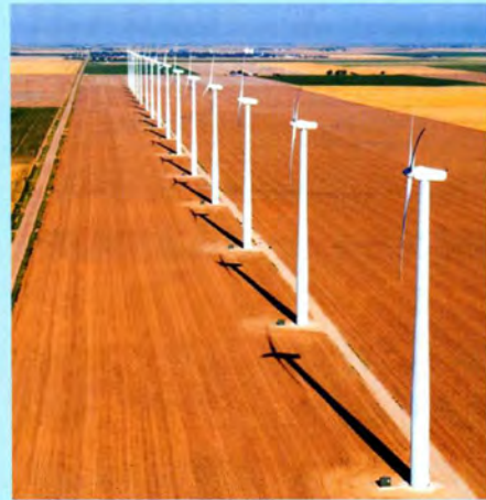
(a) 在美国堪萨斯州蒙特苏马附近，道奇城以西40km处的格雷县风力发电场，发电量为112MW；占地12 000英亩的发电场，其塔架和道路所占用地仅6英亩
