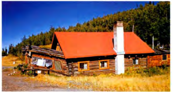
图17.26 多年冻土融化与建筑物塌陷
