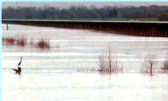
(a) 密西西比河，在新奥尔良地区的Bonnet Carré泄洪道（一种分水堰）在洪水期发挥作用，使洪水绕过新奥尔良流入南部的庞恰特雷恩湖（Lake Pontchartrain）
