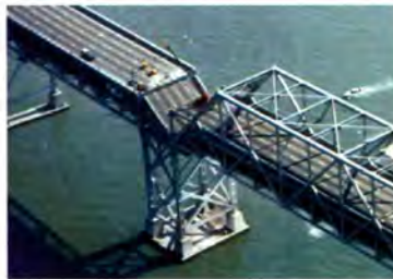
(c) 美国旧金山奥克兰海湾大桥发生了部分垮塌
