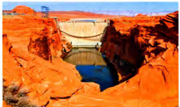
(b) 当峡谷被格林峡谷大坝拦截后, 大坝变成了科罗拉多河上的一个局地侵蚀基准面, 导致大峡谷下游的沉积物减少 [Bobbé Christopherson]
