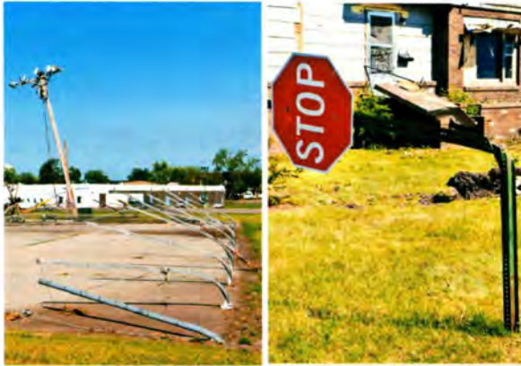
(a) 322km/h的风力造成了铁杆弯曲
