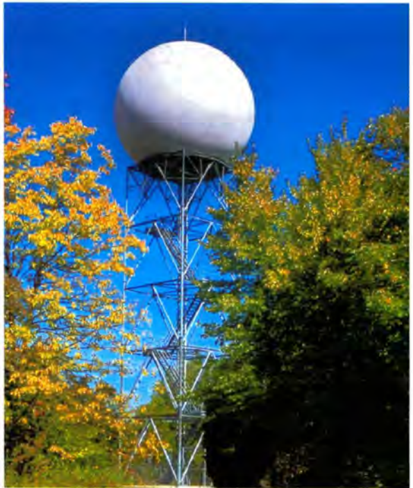
(a) 印第安纳波利斯国际机场的雷达天线设置在穹顶建筑内
