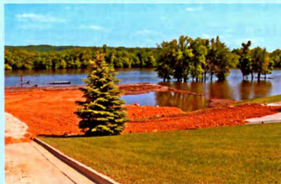
(b) 为了扩展土地面积，正在向河流中倾倒填积物；处于高水位期的河流
