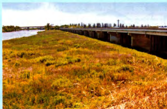
(b) 萨克拉门托（Sacramento）溢洪闸用于萨克拉门托河洪水分流，洪水通过水渠直接进入
