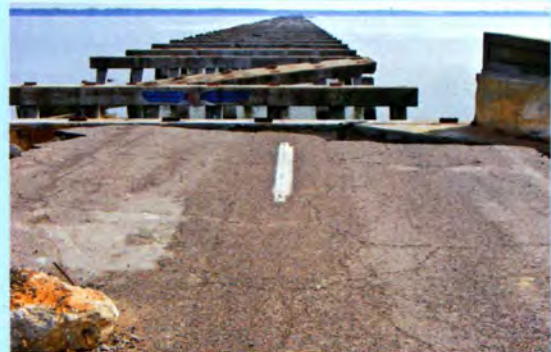
(c) 桥梁和长堤的毁坏遗址，它们分别是密西西比州的第90号桥梁和圣路易斯湾堤道
