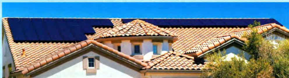
(b) 住宅屋顶设有7380W的太阳能光伏阵列发电系统；剩余电力输入电网，抵消了100%的家用电费
