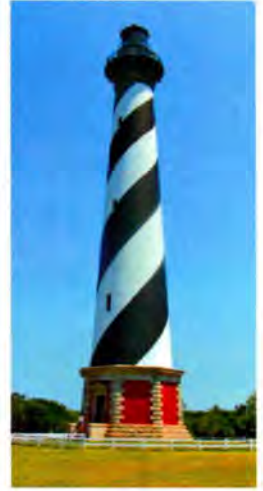
(c) 海特拉斯角灯塔新址，位置向内陆方向迁移了488m
