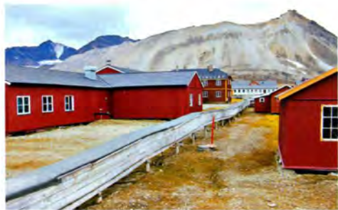
(b) 斯匹卑尔根新奥尔松研究站，支架上的房屋以及保温管道（供排水的管道被支架抬高地面）
