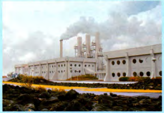
图11.25 史瓦特森吉 (Svartsengi) 地热电厂 冰岛首都西南部的史瓦特森吉发电厂，为家庭和商业提供电力和热水。电厂名称意为“黑色草甸”，原指广布冰岛地区的熔岩床。[Bobbé Christopherson]
