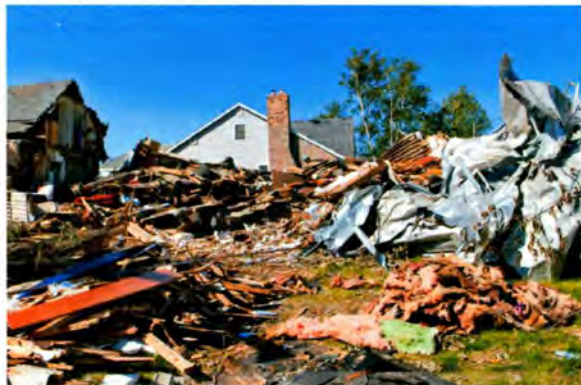
(b) 社区中心刮落的金属板，穿过这座房屋落到它的左侧
