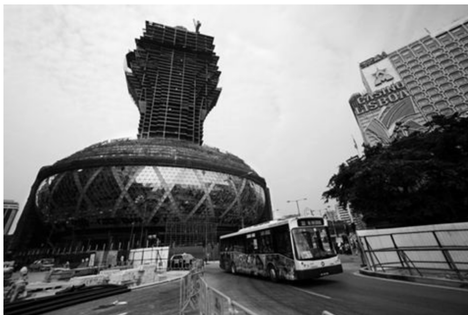
图3 建设中的新葡京赌场酒店 [23]
