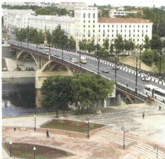
图 6-26 维捷布斯克市修复后的基洛夫大桥
