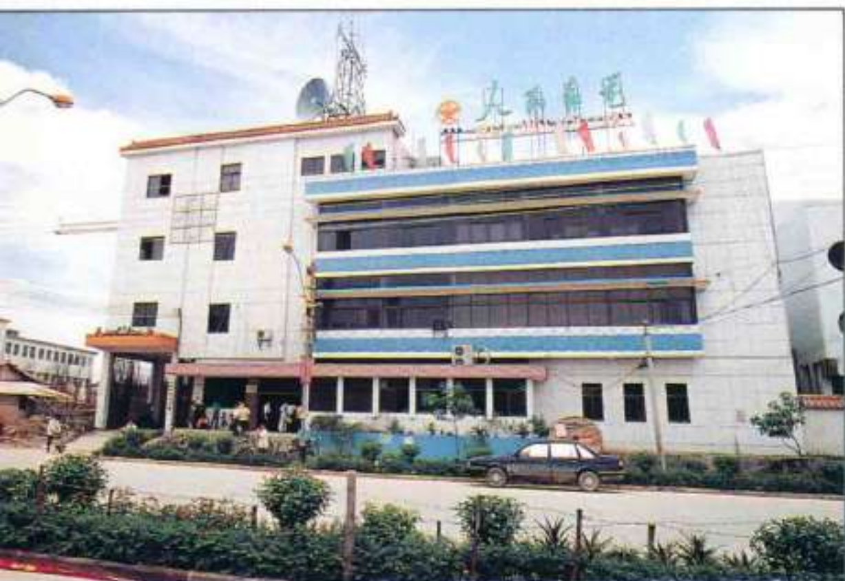
擁有 6000 門 IDD 的電訊大樓
