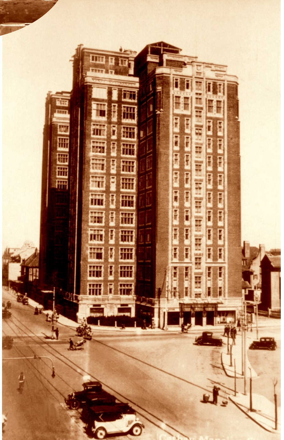
华懋公寓(今锦江饭店北楼)是维克托·沙逊于1929年所建，俗称“十三层楼”，外形呈现带有装饰艺术派色彩的乔治式建筑风格。
