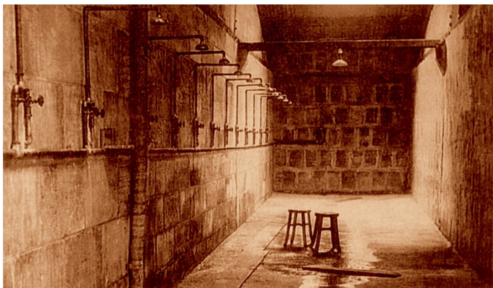
为犹太难民临时搭建的淋浴设施。
