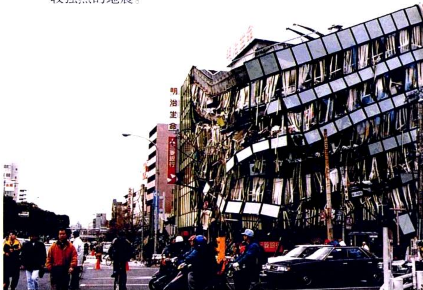
图 2-18 1995 年日本神户发生 6.9 级地震,许多楼房被摧毁。
