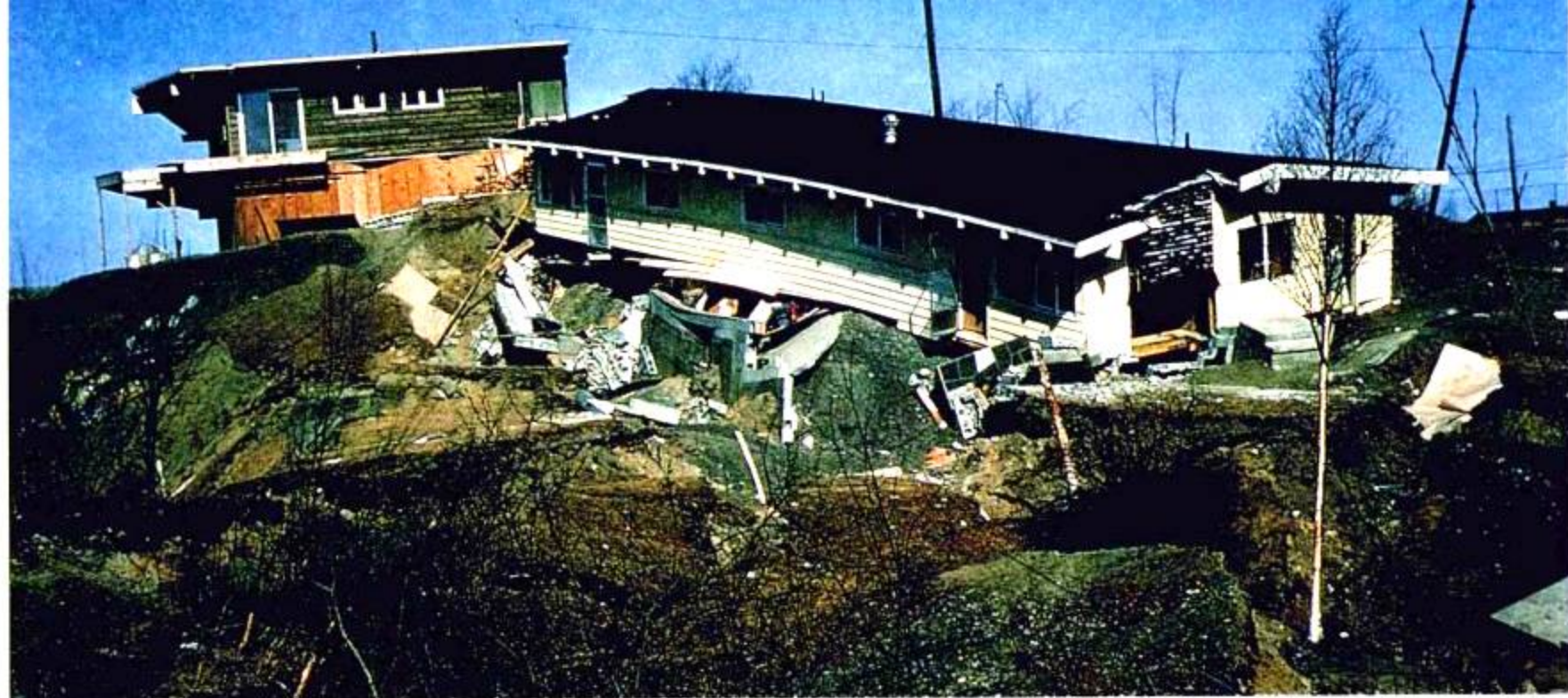
图 2-19 地震导致这座房屋下面的泥土液化。地震波能在几秒钟内将固体泥土变成液体泥浆。 提出问题 在地震危险区,人们在建房前应先考虑哪些问题?
