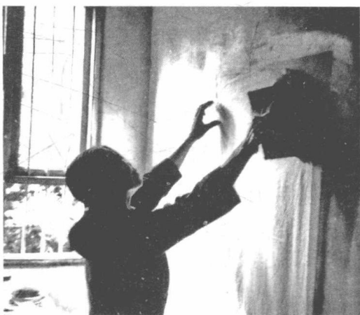
图9 刷纸匠用硬刷在墙上刷纸,作者摄于1996年
