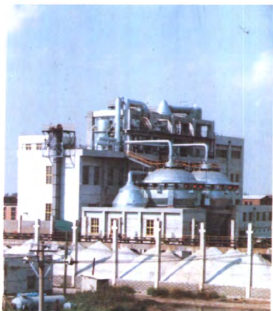
17 辽宁省营口盐场闪急蒸 发制盐装置 (辽宁省盐务局供稿)
