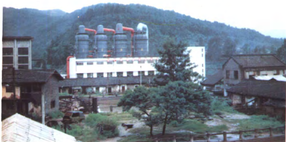
16 云南省一平浪盐矿 18 万吨/年真空制盐装置 (云南省盐业公司供稿)
