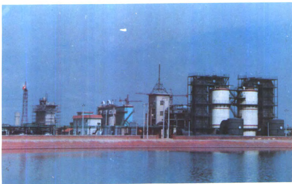
19 山东省羊口盐场制溴厂 (山东省盐业公司供稿)
