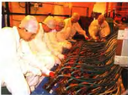
■ RGL 棒控系统电缆作业现场
