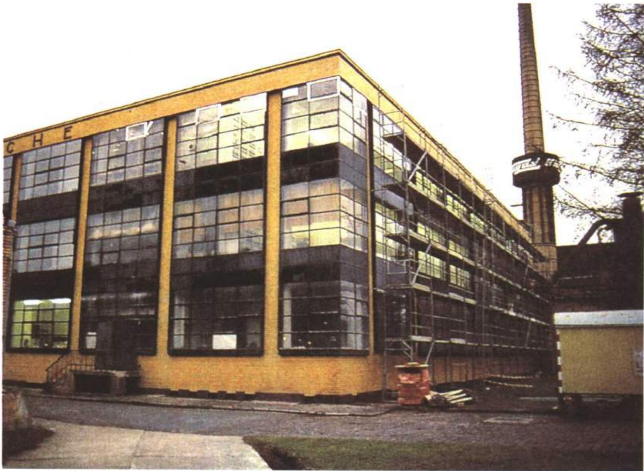
显著的特征，这种作为围护的玻璃反包在作为结构的柱子之外的做法似乎是格罗皮乌斯的发明。虽然早在很久以前，框架结构便已出现，但是似乎没有哪一位建筑师意识到围护与结构可以分离的问题，在芝加哥学派设计的诸多建筑中，围护与结构依然如从前一样混杂在了一起。但是在法古斯工厂中，玻璃被做成一个整体悬挂在了柱子的外面，这种做法把楼板与梁的存在隐藏起来了，这种特殊的玻璃的处理手法，也成为1924年格罗皮乌斯为德骚设计的包豪斯问世以前他与迈耶设计的所有公共建筑的特征，也同时出现在他们1914年为制造联盟博览会设计的示范工厂中。
