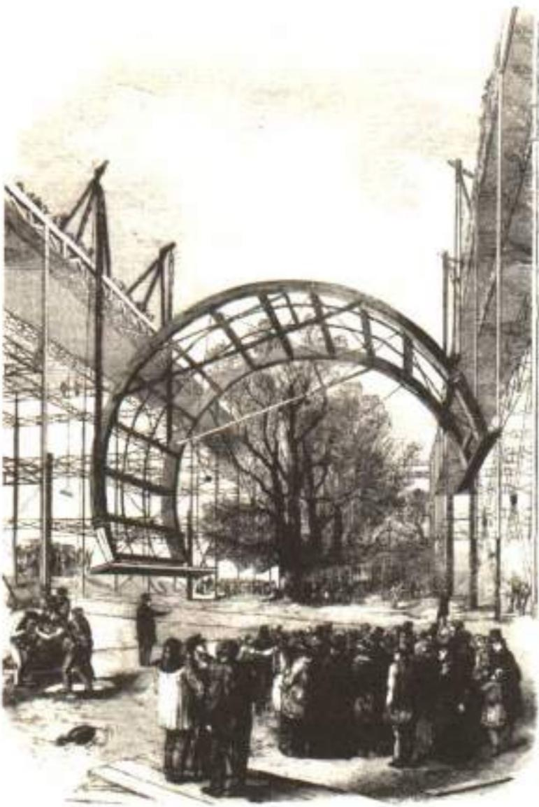
— 水晶宫的中央拱顶组件事先在地面上组装，再向上提升至固定高度。
