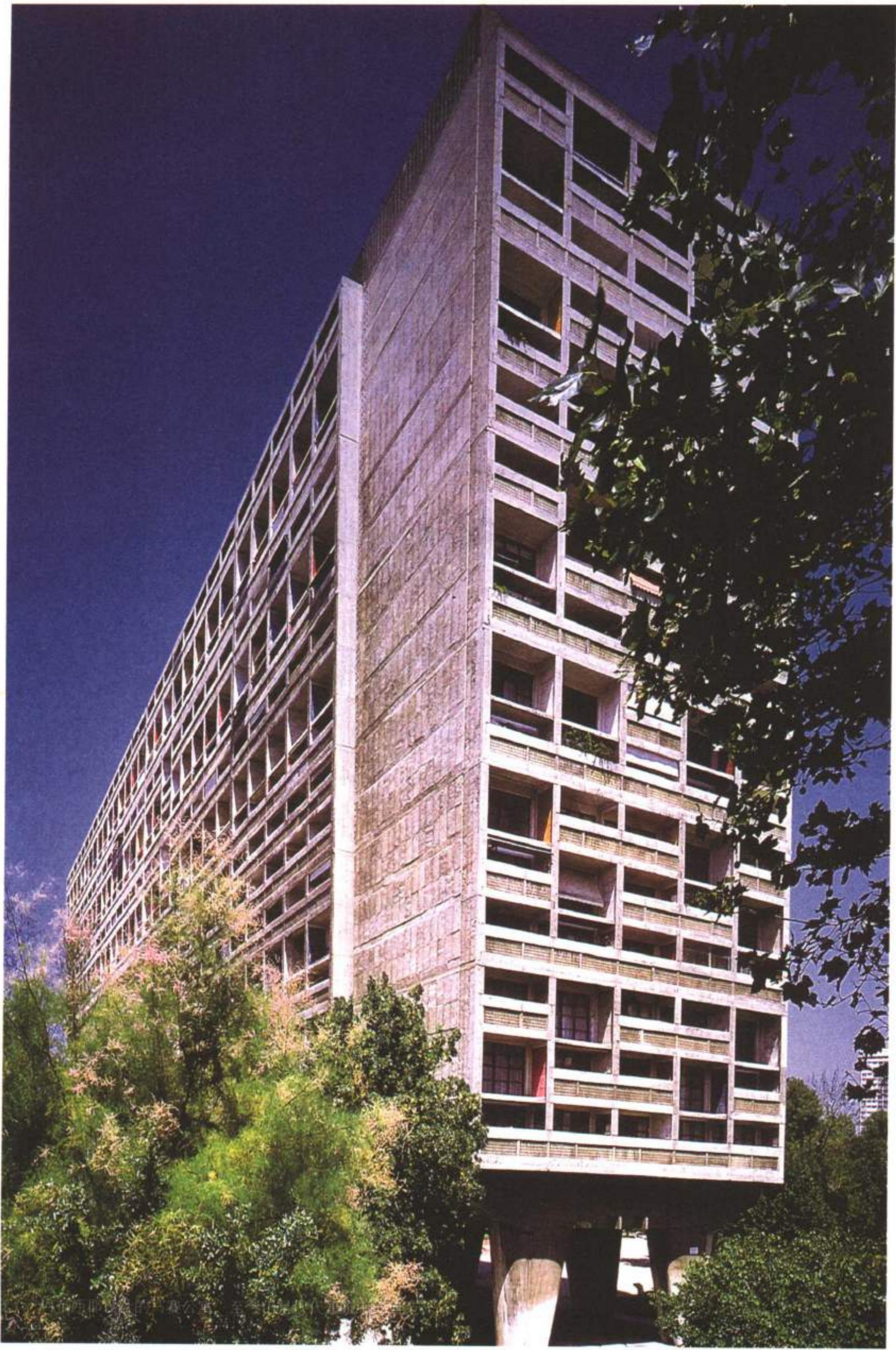
廊的圆形柱子微妙地升上来。另一个改变是原本设计的室内螺旋梯采用周圈的结构，却在施工时“代之以独立的悬臂楼梯，混凝土的拦板”。最后，许多的隔板根据建造工作的开展改变了形式，一些柱截面改成能够隐藏雨落管的形式。
