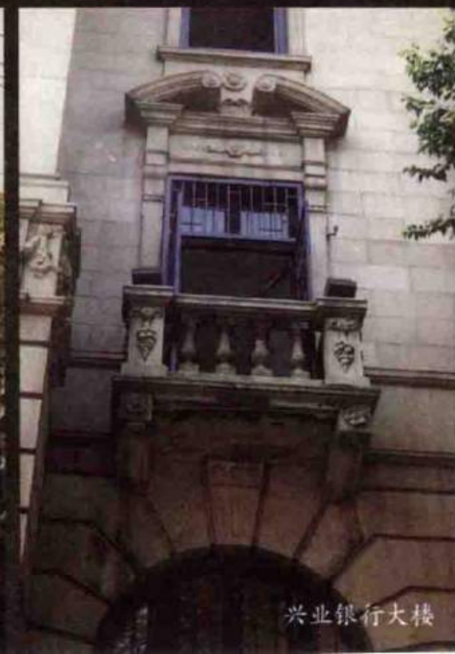
兴业银行大楼
