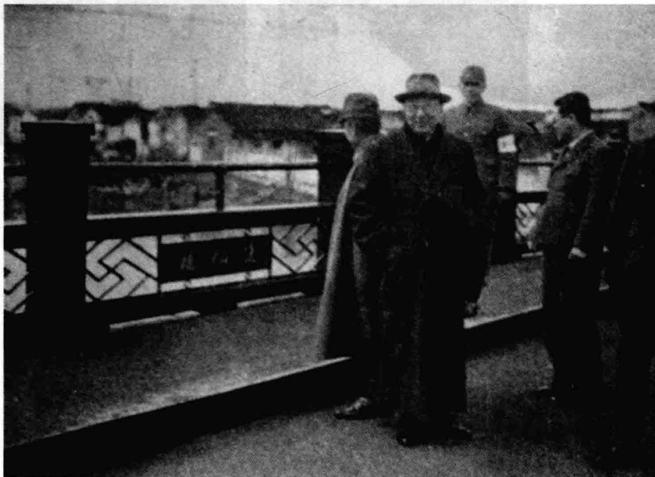
汪伪南京市市长蔡培视察刚修缮完工的逸仙桥。〔伪南京市政府秘书处编辑：《南京市政概况（民国二十九年七月至十二月）》，惠文印书馆1941年出版，第4页〕
