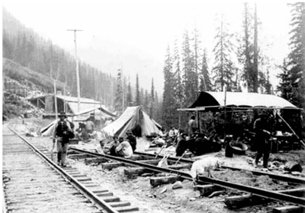
2-1 修铁路的华工
