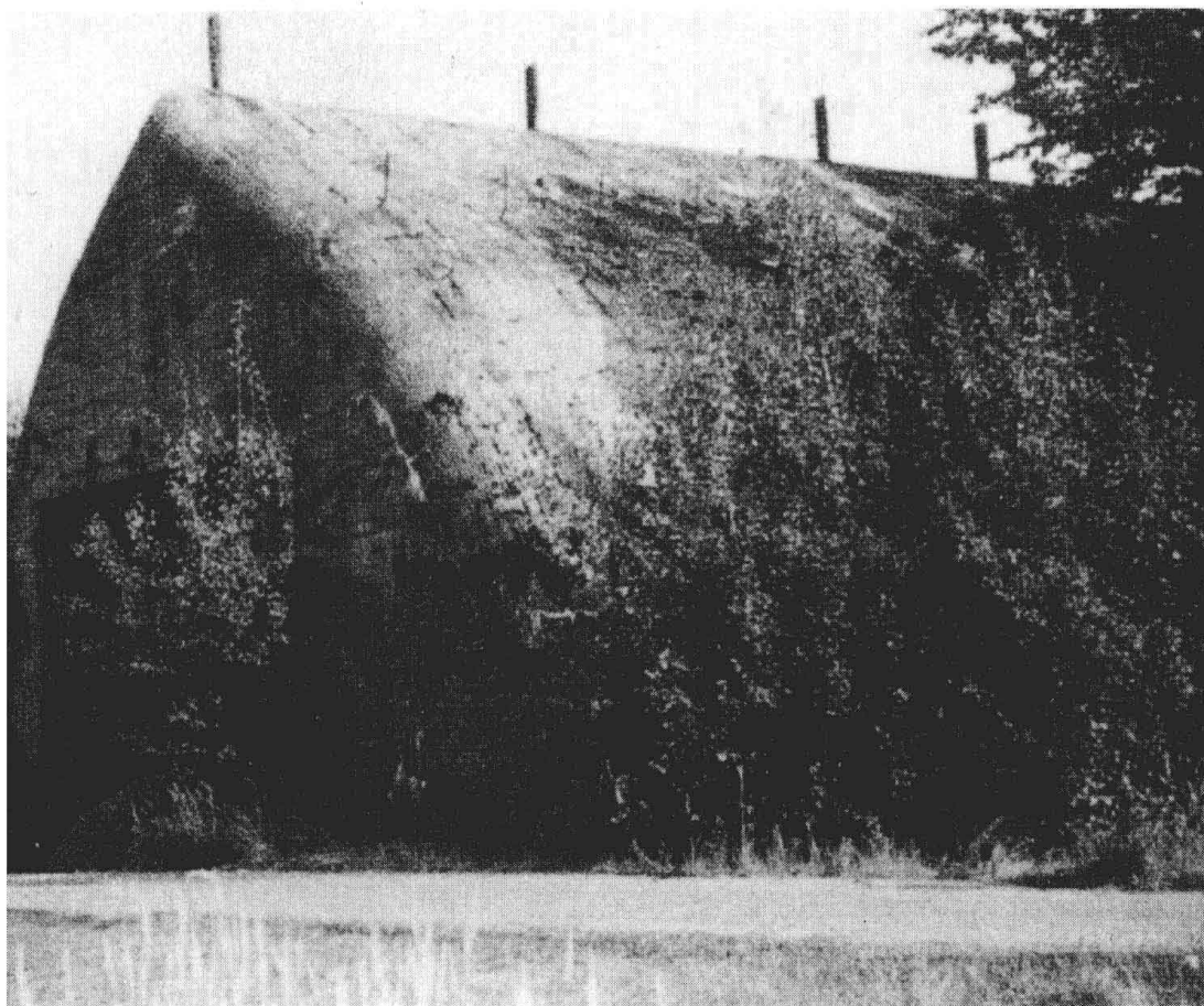
阿斯卡尼亚中部（位于罗兹以东）希特勒专列的加固混凝土库房。希特勒未曾使用过该元首总部，因为德国进攻苏联的速度过快，导致该总部被远远抛在前线后方。
