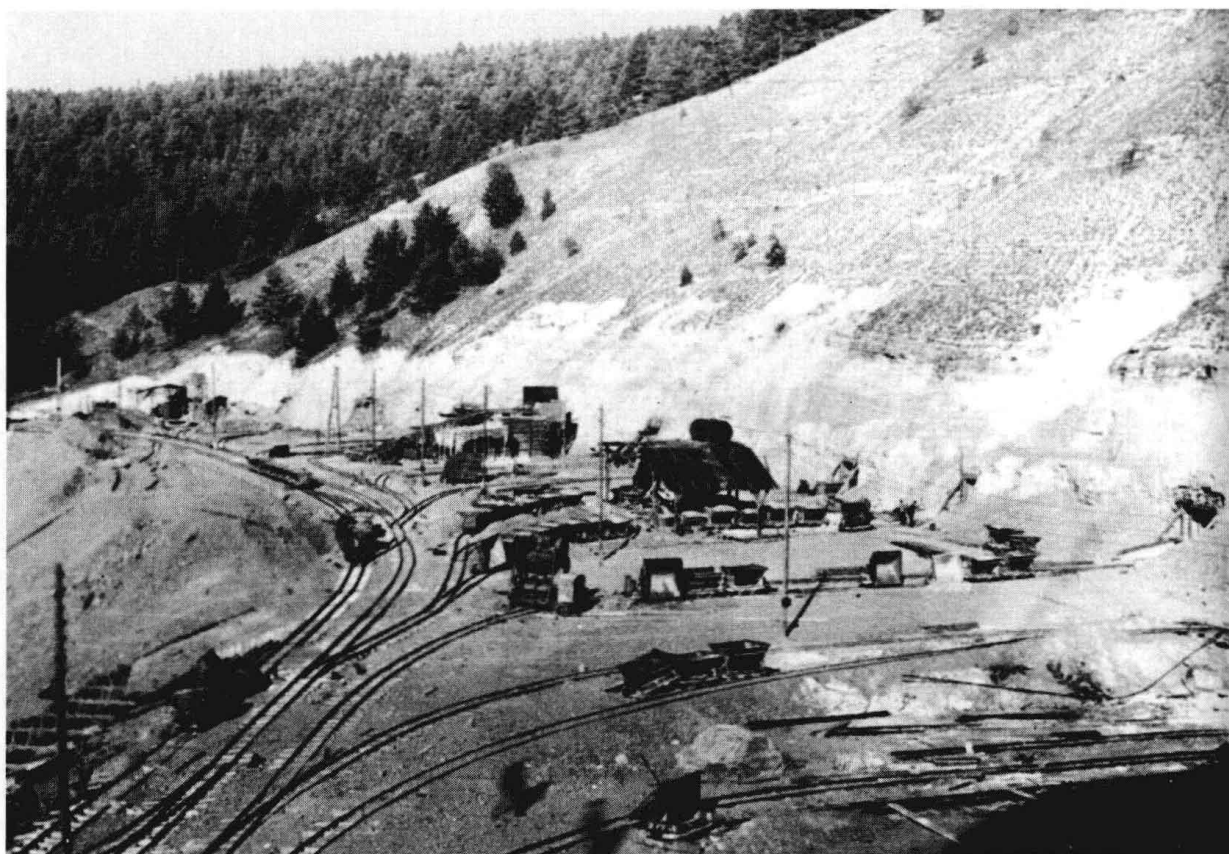
“S-III”元首总部的建筑工地西侧的工程进展。
