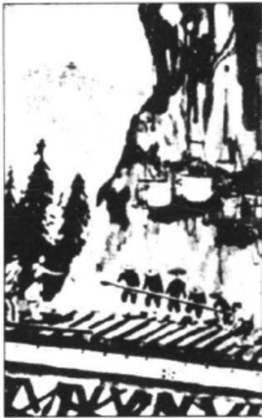
图7. 华工坐在吊篮里 修建美国铁路
