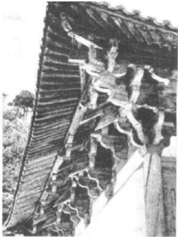
177. 佛光寺斗拱，山西五台县。南禅寺与佛光寺是现在中国仅存的两座唐代木构建筑。
