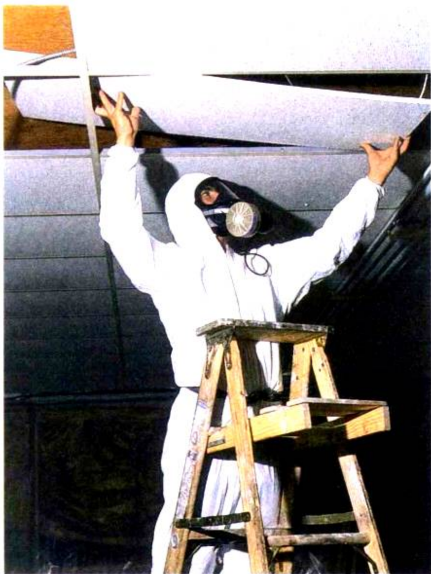
图 6-20 在知道石棉会引起癌症之前,人们常用石棉做天花板。为了保护人类的健康,一个环保工人正在拆除石棉制作的天花板。
