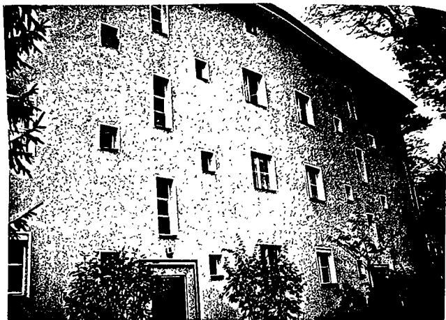
图 2.6 汤姆叔叔住宅项目，由布鲁诺·陶特设计，1926 年开工，1932 年建成。注意其平滑的外立面和凹窗——现代主义风格的鲜明特征——以及整体结构上的微微弧度。拍摄者为作者本人。
