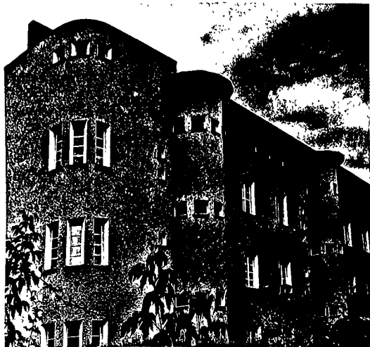
图5.2 布鲁诺·陶特和马丁·瓦格纳设计的柏林-布里茨住宅项目，建于1925—1927年。当时，住宅建设的宗旨是为居民提供“光线、空气和阳光”，而布里茨就是很好的范例。柏林-布里茨也是另一种别样的现代主义风格。注意观察那些建筑圆角和圆形楼梯井，都是那些严格遵循功能主义的设计师所痛恨的——他们推崇直线和90度直角。图片为作者所摄。
