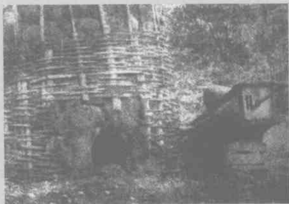
|| 「大办钢铁」时的竹制「土高炉」。
