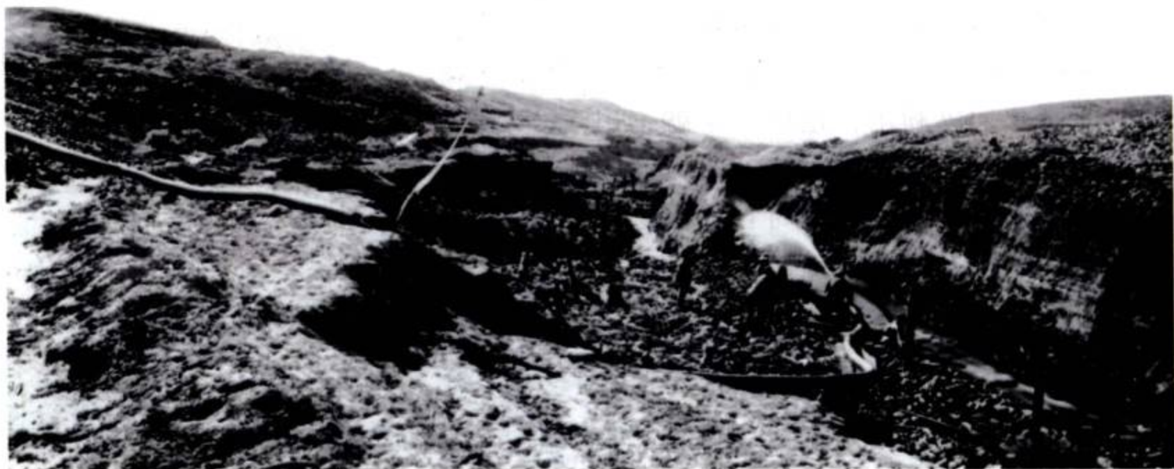
正在液压开采中的弗吉尼亚州附近的金矿山金矿
