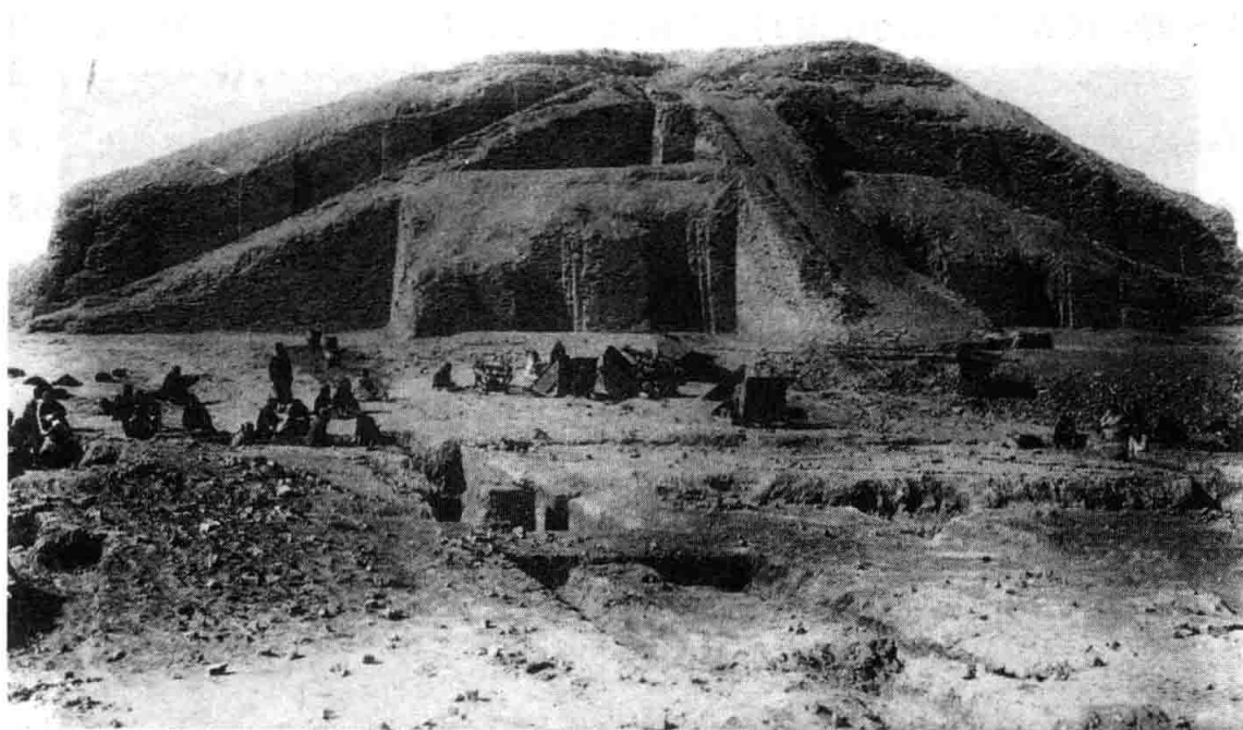
图 9.10 乌尔塔庙的挖掘现场。乌尔塔庙修建于公元前第3千纪，重修于公元前6世纪。
