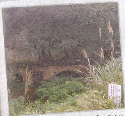
已經半淹在水面下的七坑坑口
