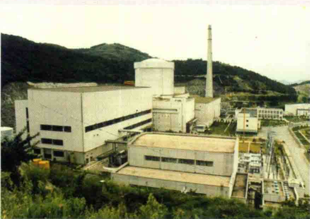
秦山核电站一期工程常规岛
