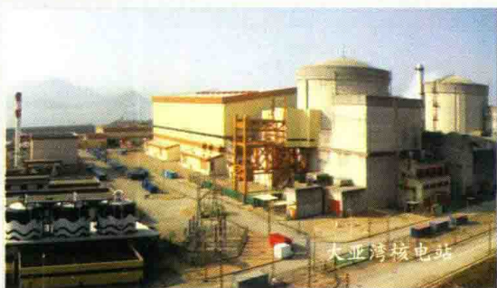
公司承担了该工程常规岛土建工程施工。
