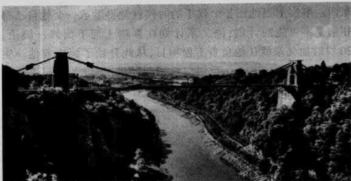
图 228 布鲁内尔,克里夫顿悬挂式大桥
