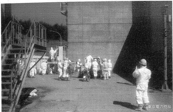
1F 廠區內的移動式迷你倉庫設置作業。（攝於 2011 年 3 月 18 日）
