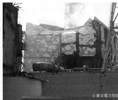
爆炸後4號機反應爐廠房的外觀。（攝於2011年3月15日）
