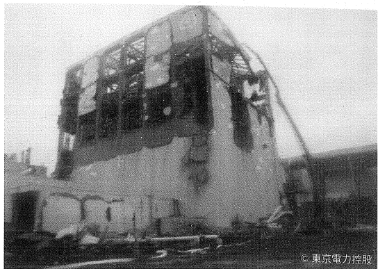
消防車從福島第一核能發電廠4號機注水的樣子。(攝於2011年3月22日)
