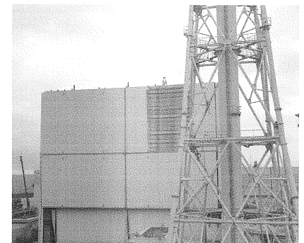
為了取出用過核燃料，目前正在進行拆除廠房遮蔽罩的作業。（攝於2016年1月14日）
