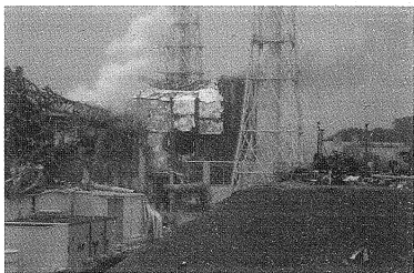
事故後的3、4號機 (攝於2011年3月16日)
