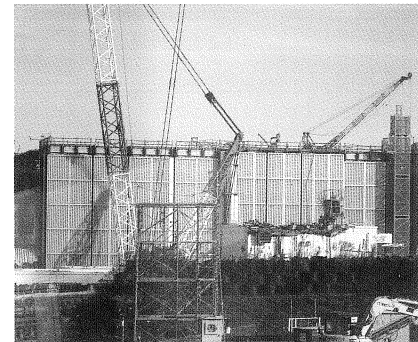
目前正在撤除用過核燃料池內的瓦礫，同時準備設置新的燃料取出專用遮蔽罩。（吉川彰浩攝於2015年11月18日）
