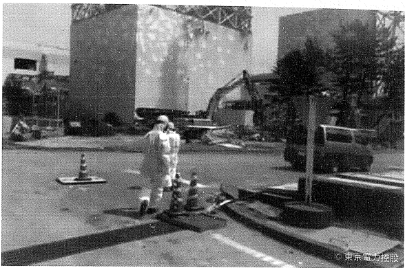
用無人重型機械撤除瓦礫。(攝於2011年5月6日)
