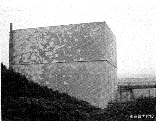
2 號機反應爐廠房外觀。(攝於 2012 年 8 月 15 日)
