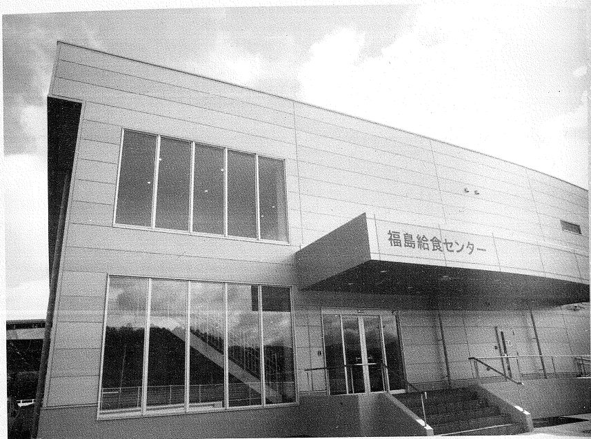
1樓有烹調空間，2樓有會議室和參觀通道。
