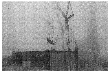
吊起 3 號機用過核燃料池內的燃料裝卸機 (攝於 2015 年 8 月 2 日)
